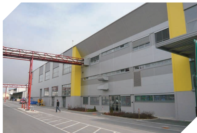
Proizvodni obrat za premaze na vodni osnovi
